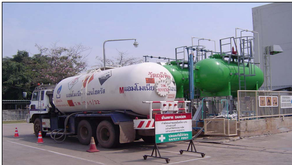
รูปที่ 5-3 การขนถ่ายแอมโมเนียจากรถแท็งก์เข้าสู่ถังรับที่โรงงานผู้ใช้
