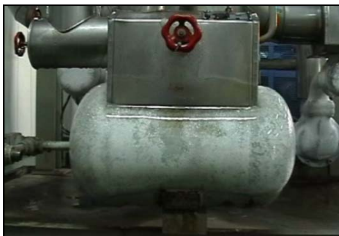
รูปที่ 8-1 บริเวณถังพักน้ำมันหล่อลื่นที่ต้องถ่ายน้ำมัน
