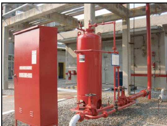
ชุดฉีดโฟมดับเพลิง (Foam Monitor)
