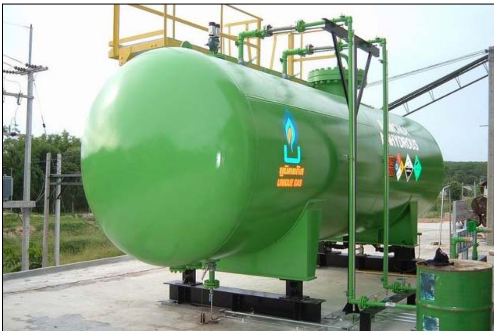
รูปที่ 3-2 ตัวอย่างถังเก็บแอมโมเนียแบบรับความดัน รูปทรงกระบอกปลายมน
