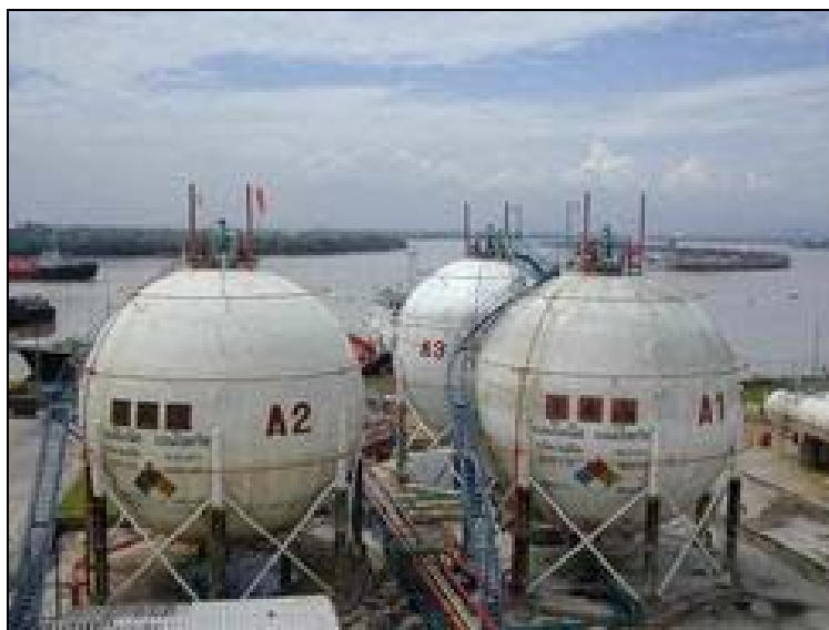
รูปที่ 3-1 ตัวอย่างถังเก็บแอมโมเนียแบบรับความดัน รูปทรงกลมขนาดใหญ่ ณ บริเวณท่าเรือ
